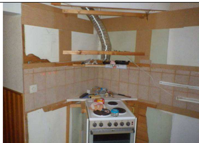
28. Yläkerran asunnon keittiötä on osin purettu
