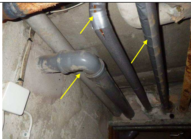
37. Käyttövesijohtoja ja viemäreitä on uusittu
