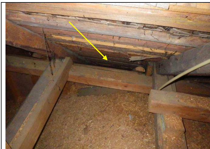
19. Tuuletusrakoa purueristyksen ja vesikatteen aluslaudoituksen välissä
